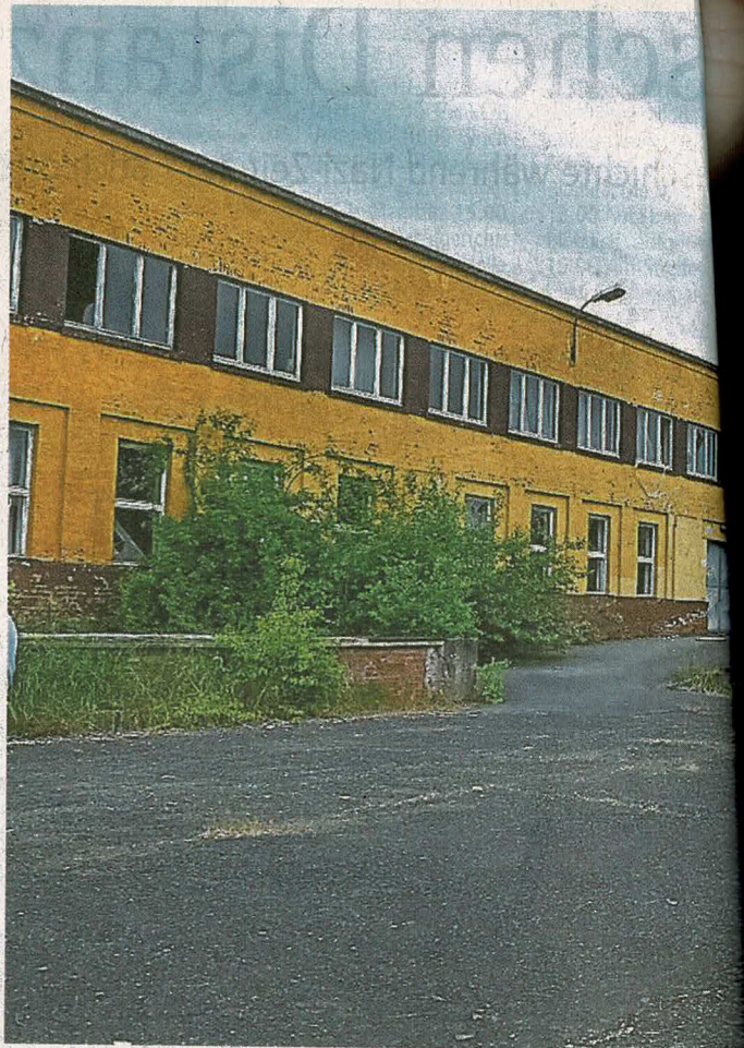
Noch hat der Abriss am ehemaligen Omniplast-Gelände nicht begon-
